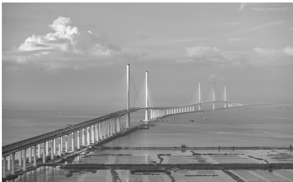
黄茅海跨海通道实景照 1
