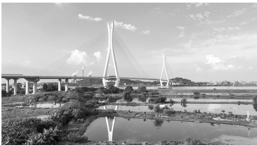
富龙西江特大桥实景照 1
