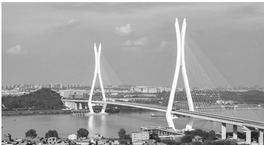
富龙西江特大桥实景照 2
