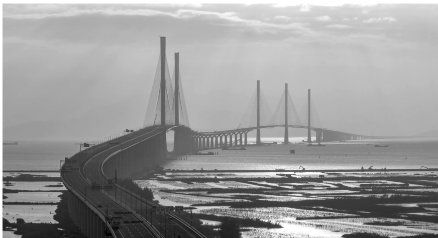
黄茅海跨海通道实景照 2
