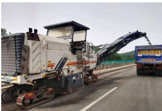
图 7.4.2 沥青路面铣刨及铣刨后表面观图
