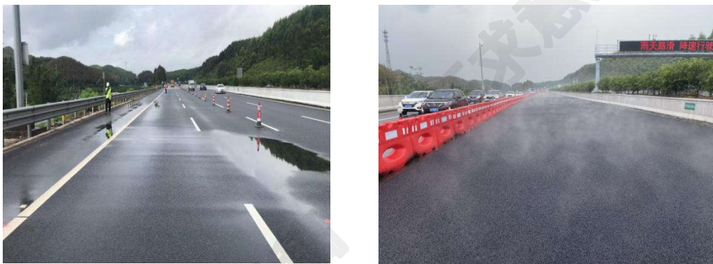
图 C.3 排水路面加铺前后雨天路面情况示意图
