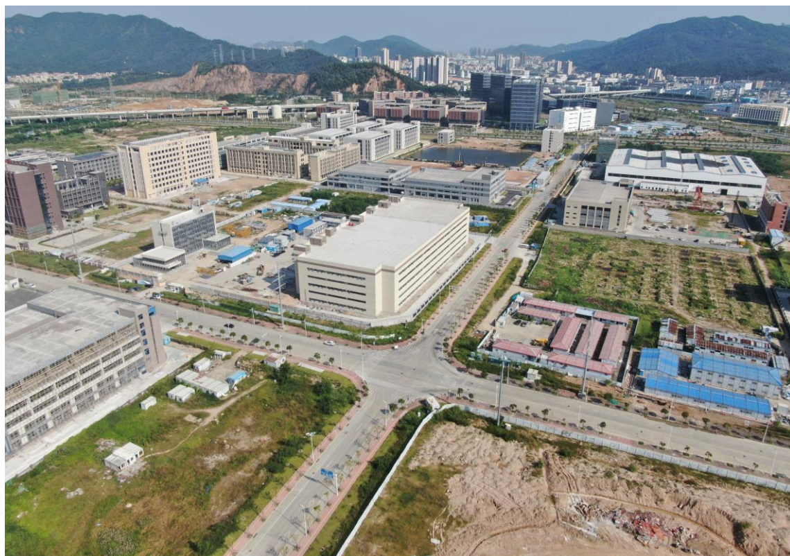
场地内已建建筑、道路、在建工地
