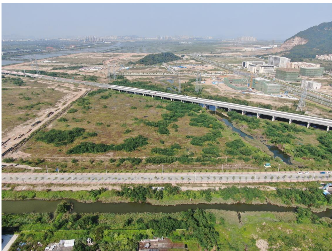
场地北侧未开发建设地块复绿（两路之间部分）、现状沟渠、已建道路
