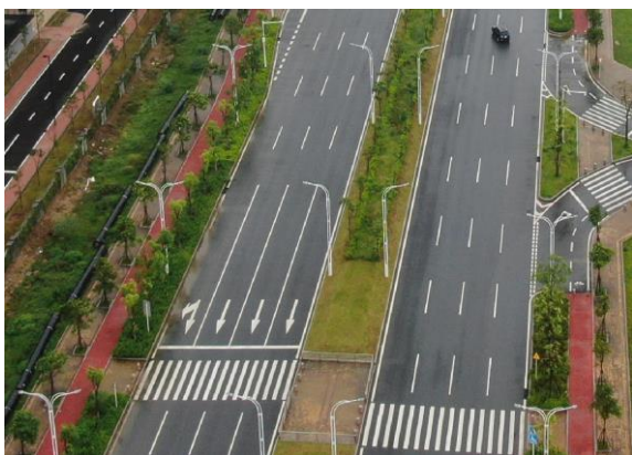
道路完工现状
