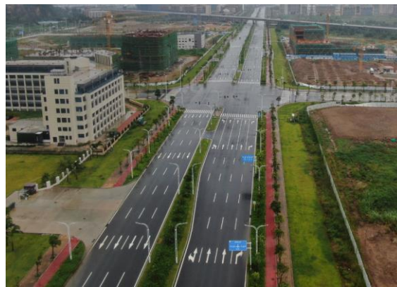
道路完工现状
