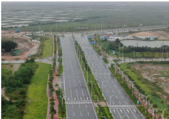
道路完工现状
