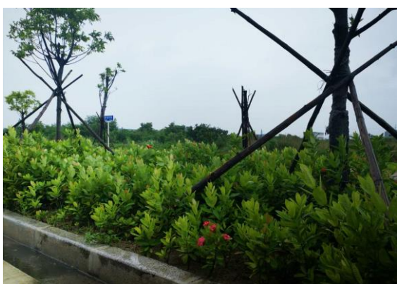
道路完工现状
