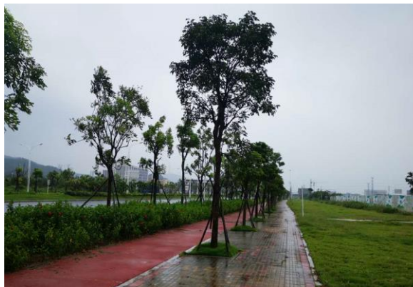
道路完工现状
