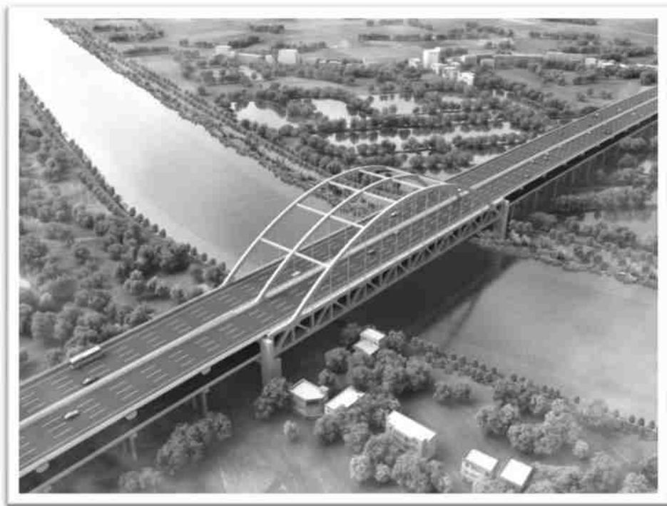
横门特大桥采用了高速公路与民古路合建的双层桥梁,上下层均为双向八车道标准。主桥初步推荐采用主跨 880 m 的单跨悬吊钢桁梁悬索桥;主桁为华伦式桁架。全缆跨度布置为  $290 + 880 + 290 = 1460$  m,边主跨比 0.33,矢跨比 1/10。
