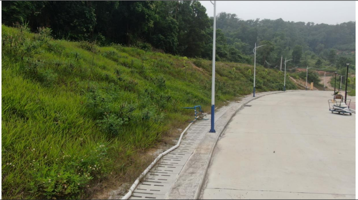
位 置：环校路 K0+460~K0+600 现场情况：沿环校路设置排洪渠。
