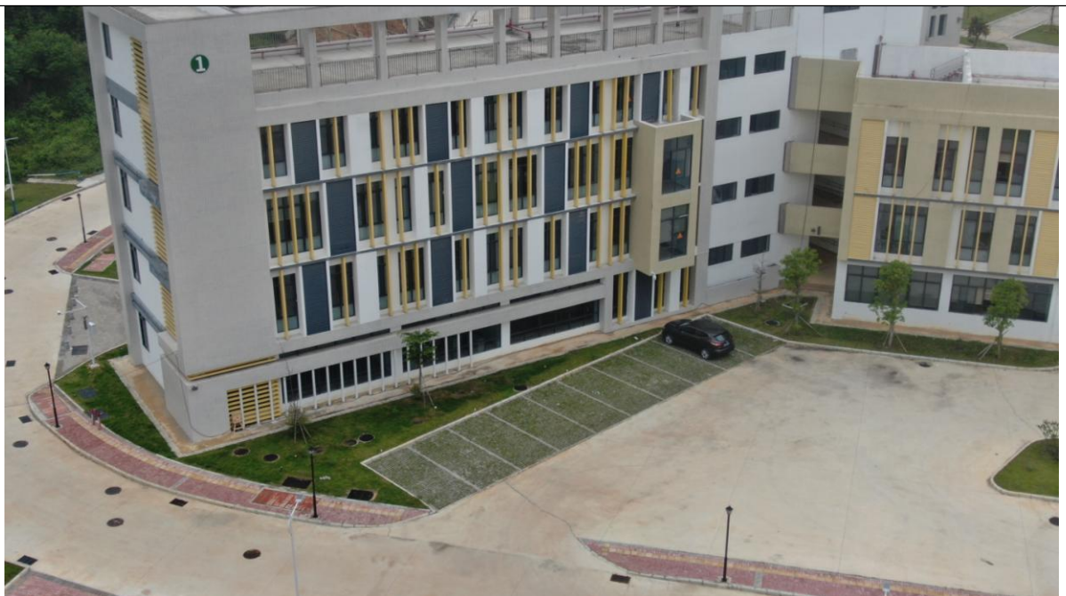
位 置：G-1#楼 现场情况：1#教学办公楼周边景观绿化区实施景观绿化工程。
