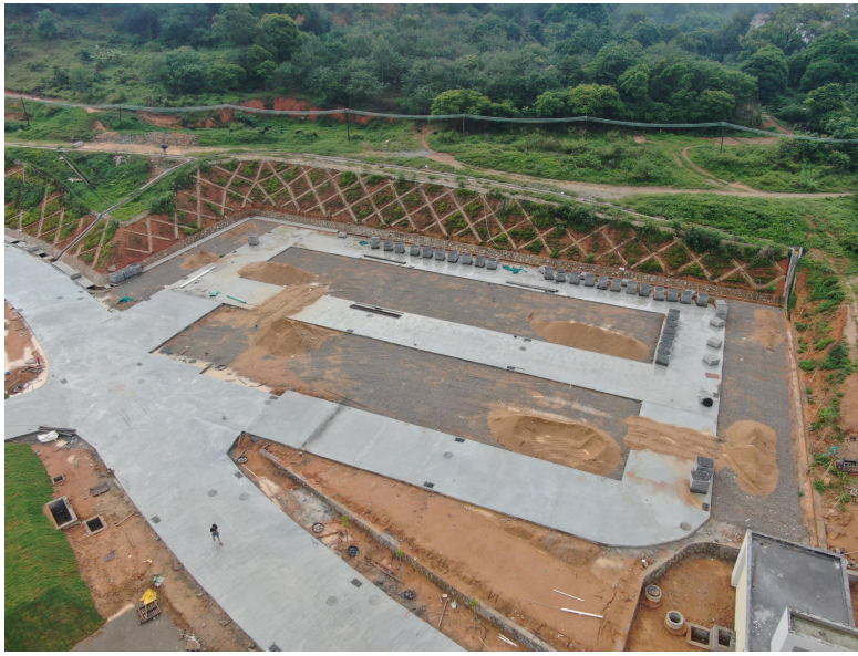
时间：2021年1季度 现场情况：停车场边坡实施骨架护坡
