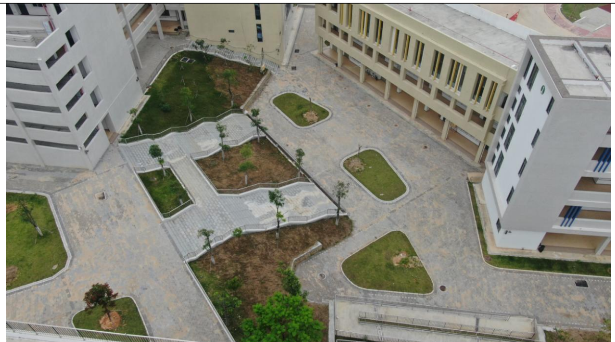
位 置：G-2#楼 现场情况：2#教学办公楼周边景观绿化区实施景观绿化工程。
