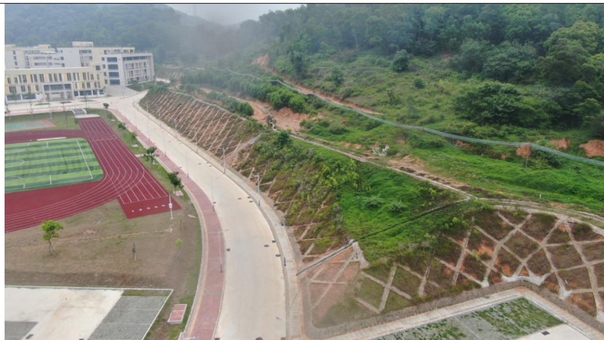
位 置：环校路 K0+134~K0+460 现场情况：边坡落实骨架植草护坡、截水沟、急流槽等措施。
