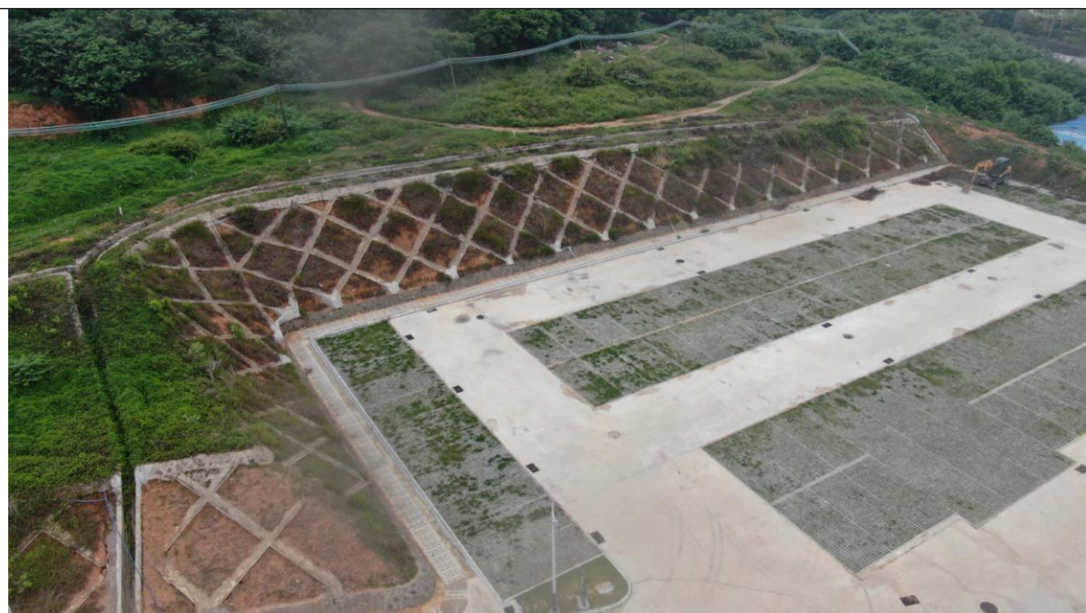
位 置：停车场 现场情况：边坡落实骨架植草护坡、截水沟、急流槽等措施。
