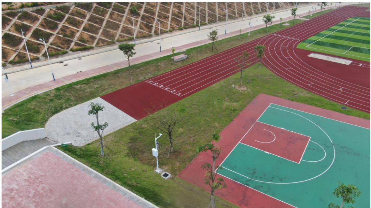
位 置：体育运动场片区 现场情况：体育运动场周边完成景观绿化恢复。
