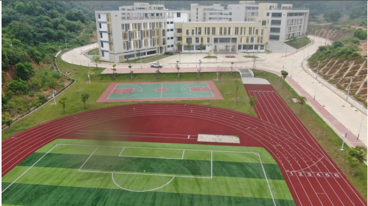
位 置：体育运动场片区 现场情况：完成橡胶场地铺设。
