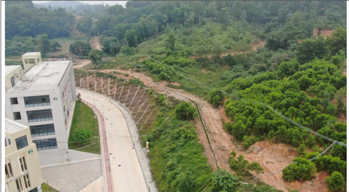
位 置：环校路 K0+730~K0+820 现场情况：边坡落实骨架植草护坡、截水沟、急流槽等措施。
