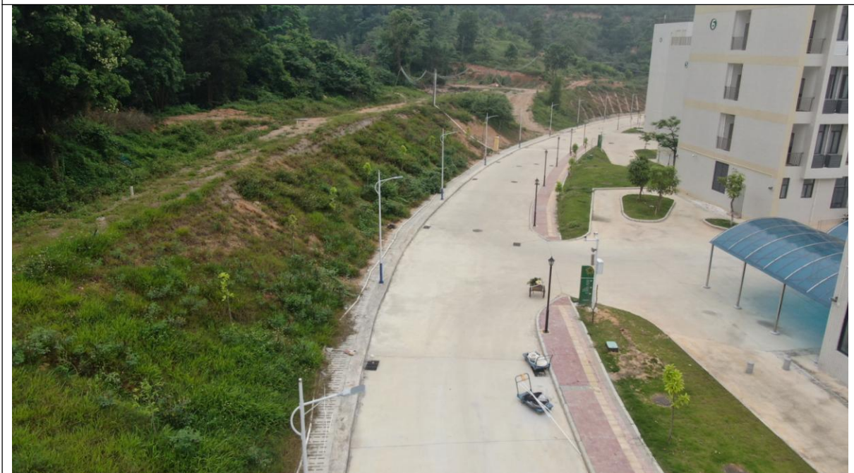
位 置：环校路 K0+460~K0+600 现场情况：边坡落实喷薄植草护坡、截水沟等措施。
