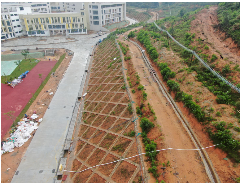
时间：2021年1季度 现场情况：道路已进行硬化，开挖边坡上游布置截水沟，边坡实施菱形骨架护坡，骨架内实施植被恢复措施，效果较差
