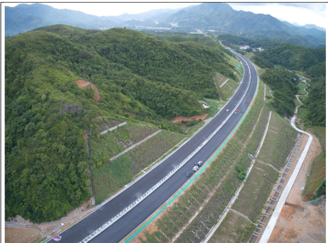
路基边坡防护、排水设施（改路）
