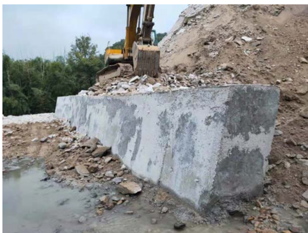
弃渣场已设置挡土墙
