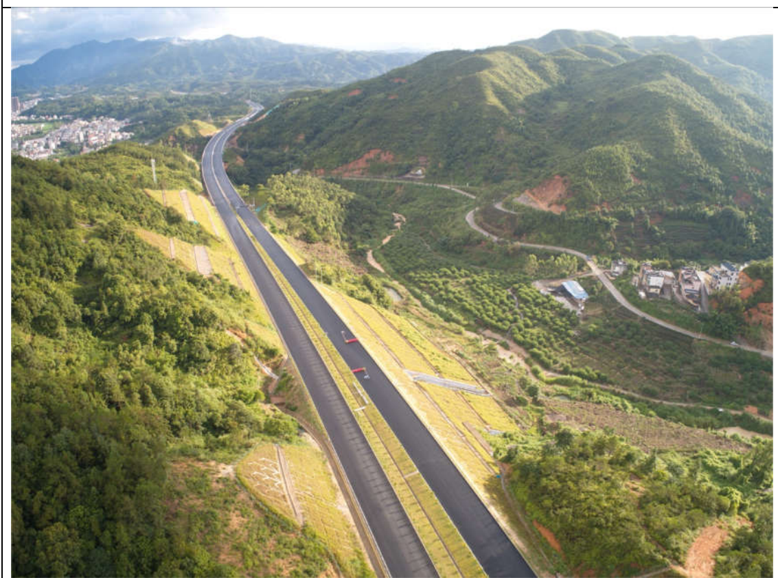
路基边坡防护、排水设施
