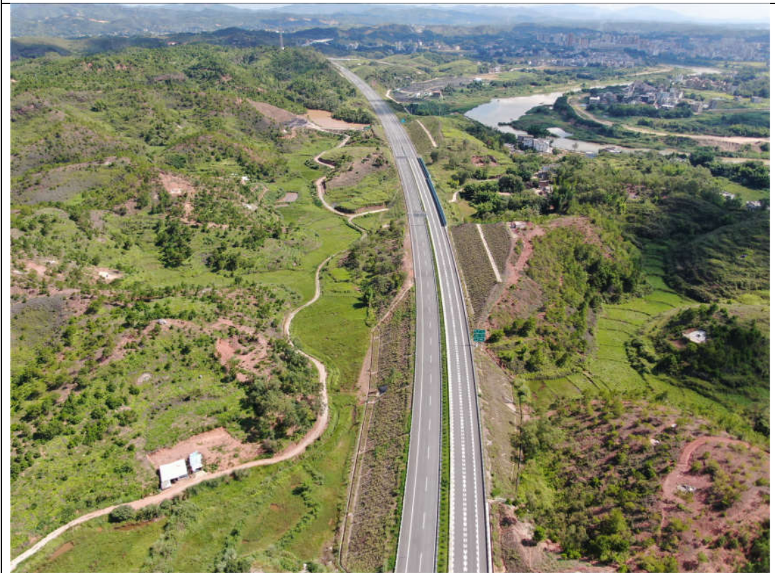
路基边坡防护、排水设施
