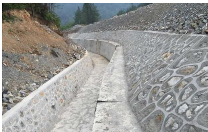
弃渣场排水沟
