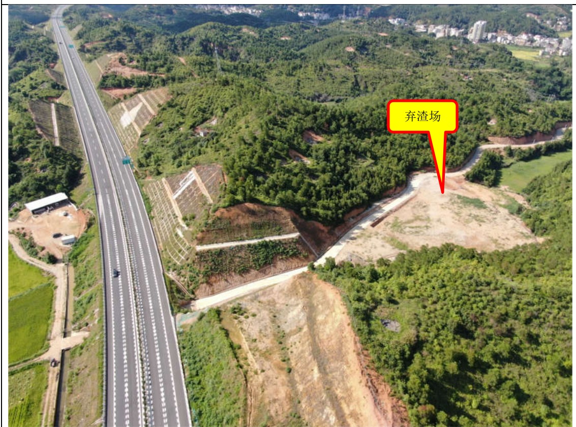
TJ4 标 1#弃渣场 (移交地方利用)
