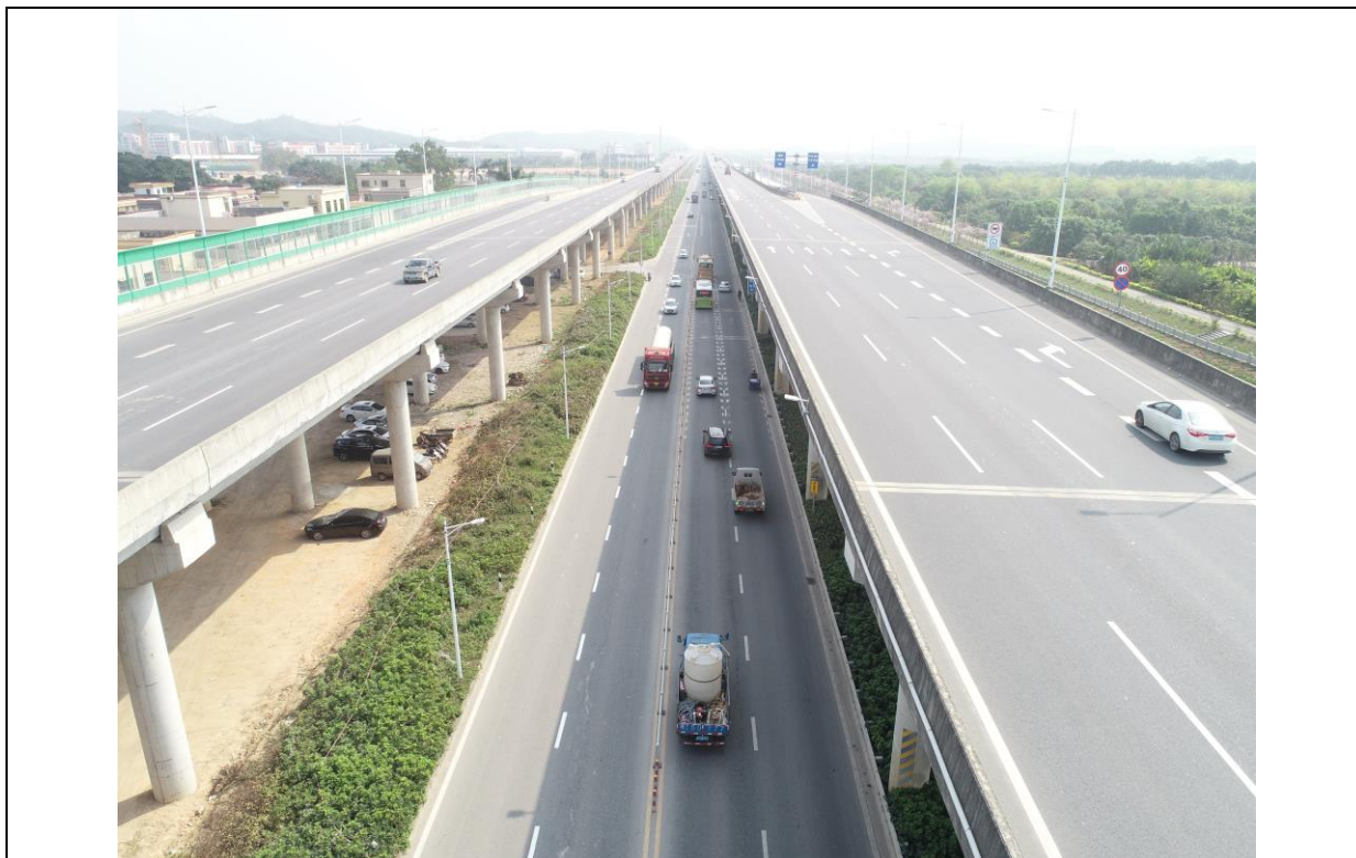
路面工程及绿化带（桥底预留用地部分作为临时通道及停车场）
