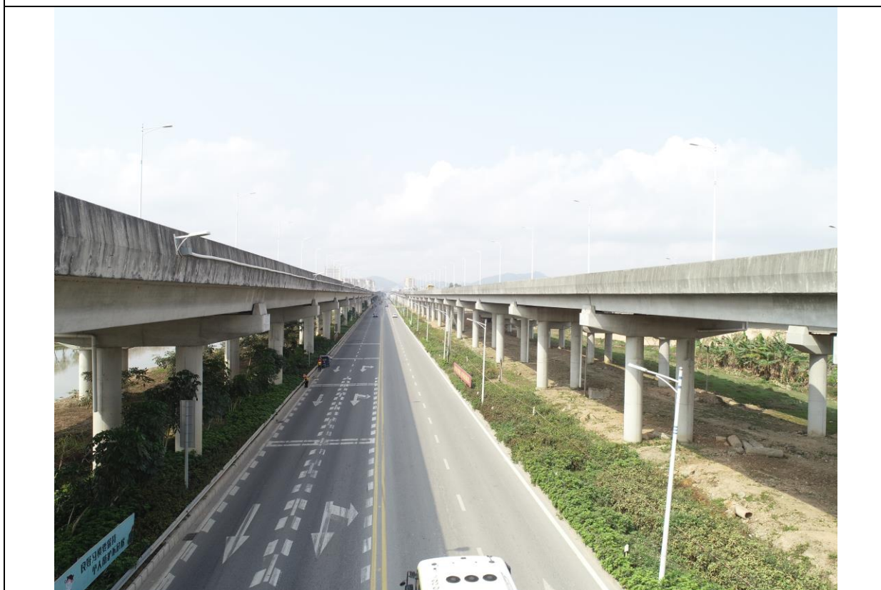
绿化带及桥预留用地现状（桥底绿化为东部快线项目实施）
