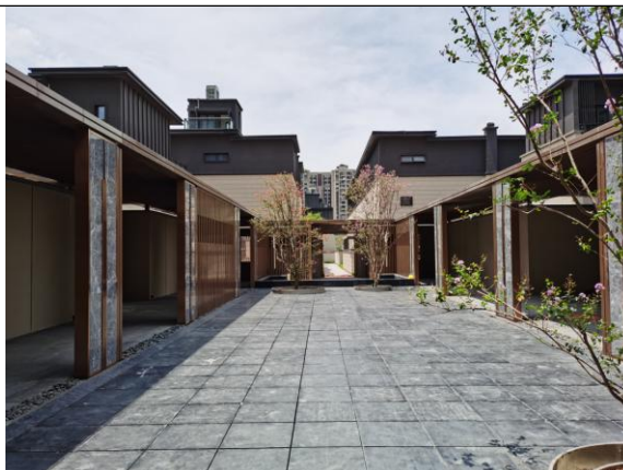
现场: 建筑物已完成建筑物施工, 道路广场区完成绿化, 绿化工程区完成园林绿化。
