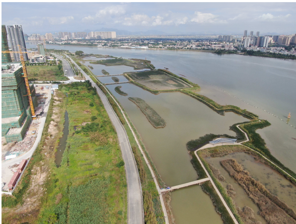
水土保持设施现状（南往北拍摄）
