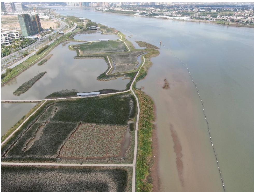
水土保持设施现状（南往北拍摄）
