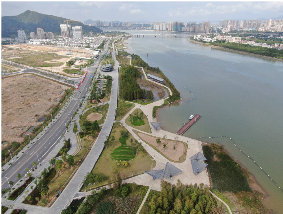
水土保持设施现状（南往北拍摄）
