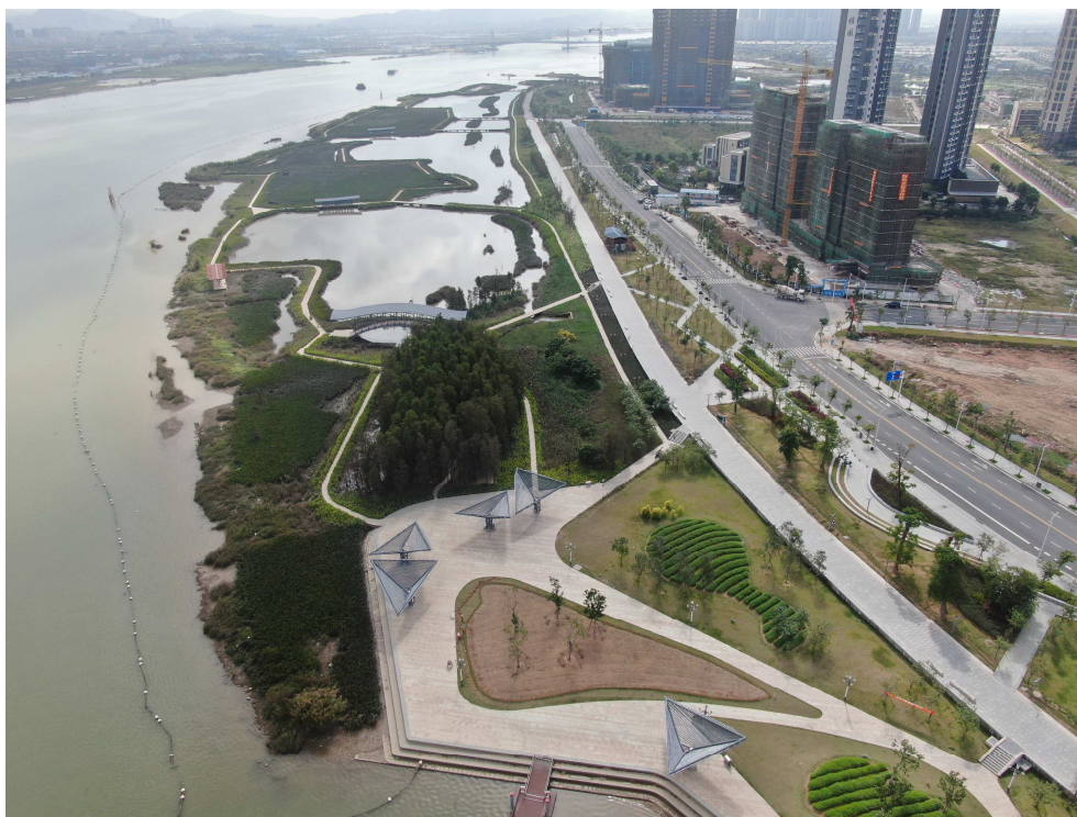
水土保持设施现状（北往南拍摄）
