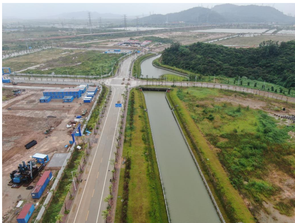
生态渠底绿化、控制绿地绿化及亲水平台生态铺装
