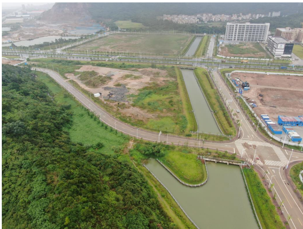
排洪渠中心岛绿化、控制绿地绿化
