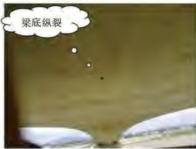
图6 41#孔箱梁底板纵裂
