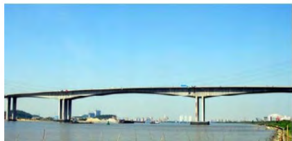
图1 海心沙珠江大桥成桥图
