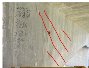
图2 箱外腹板3/8跨处斜向裂缝
