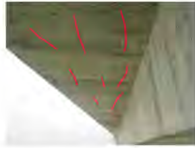
图7 40#跨7/8跨处右侧翼板裂缝分布情况
