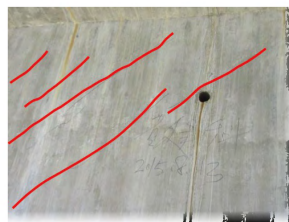
图3 箱外左腹板3/8跨处斜向裂缝
