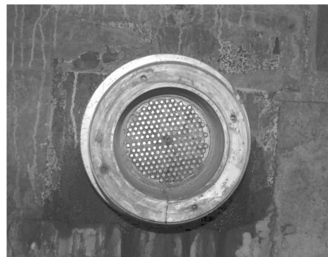
图 3 锚具轻微锈蚀情况
