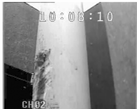
图 2 斜拉索 PE 破损图
