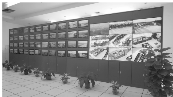
图7 龙江监控中心电视墙现状(改造后)
