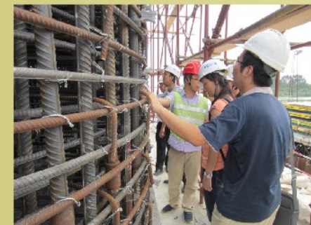
参观索塔钢筋绑扎
